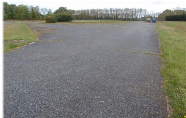
J4.2 – Réseaux routiers
